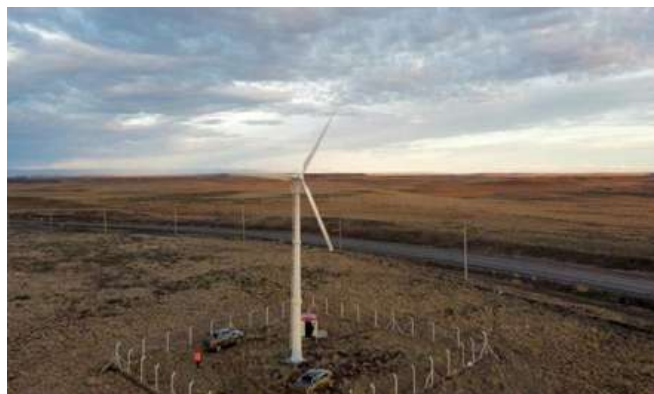
Turbina eólica Cabo Domingo - Río Grande
