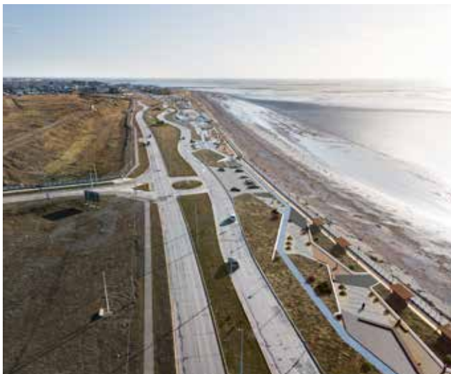
Nuevo muro costanero
